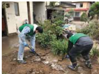
堆積土砂のかき出し
